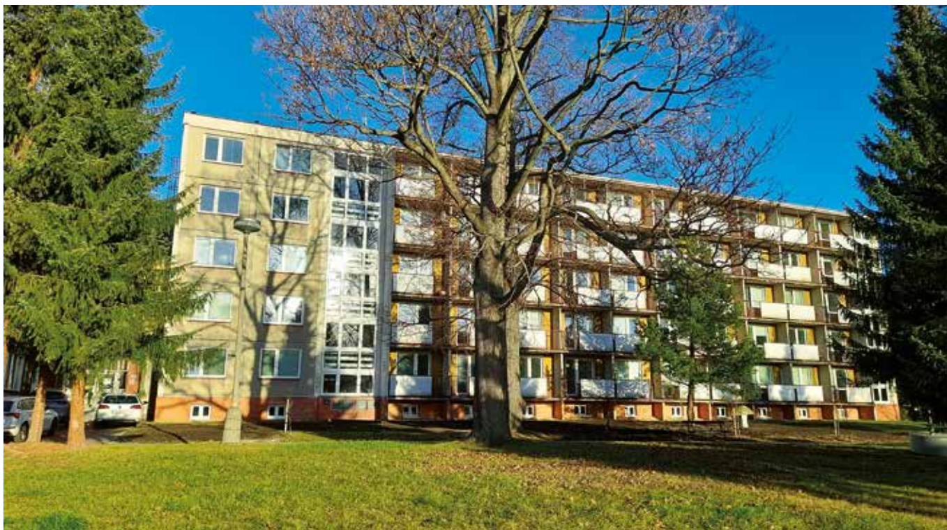
Pavilon B, kde má zázemí dětské, chirurgické a rehabilitační oddělení, prošel modernizací
