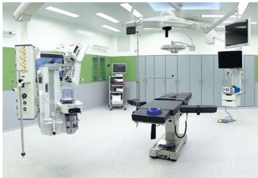
Súčasťou nového urgentu je aj úplne nové prístrojové a technologické vybavenie
