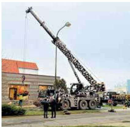
Příprava nového pracoviště neomezila ostatní provoz prostějovské nemocnice
